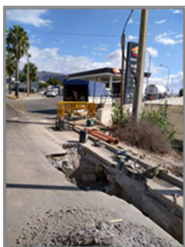
OBRAS DE PROLONGACION DE RED
