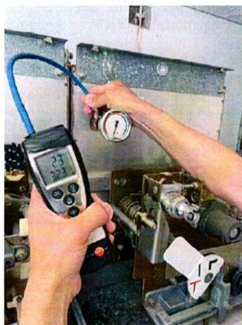
CELDA DE PROTECCION (TRAFO 2)
