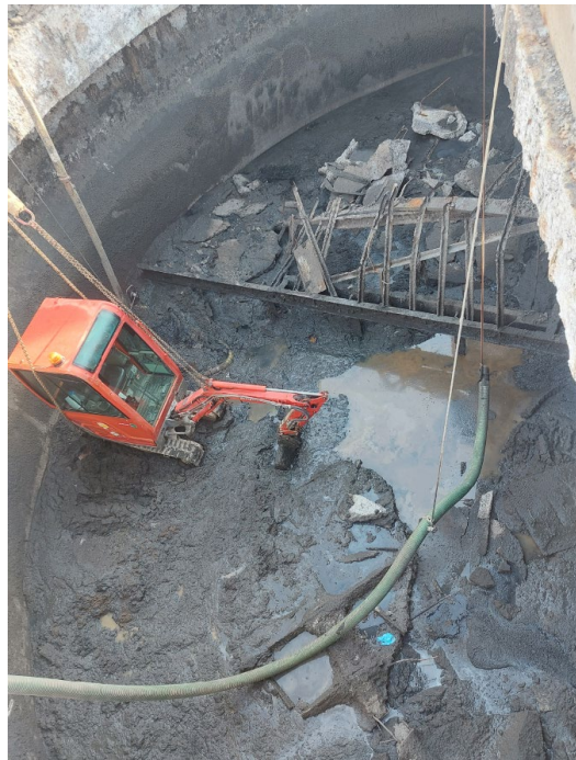
Estado inicial limpieza.
