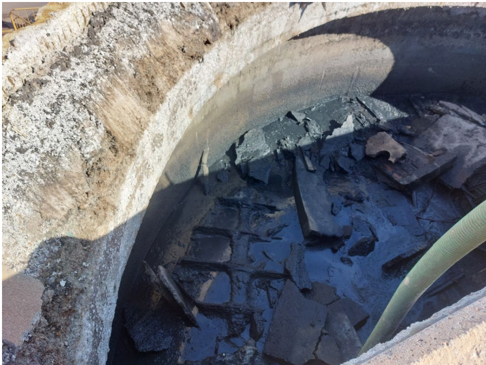
Estado inicial limpieza.
