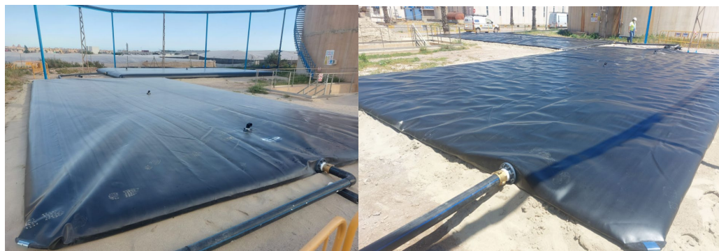
Dep. Provisionales instalados.
