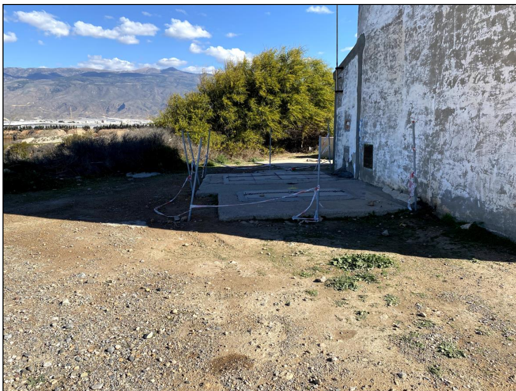
Fotografía 1.- Detalle de las arquetas de bombeo para vertido al Dominio Público Marítimo-Terrestre de la Depuradora de El Ejido. Ubicación de la tubería de vertido a Domino Público Hidráulico.
