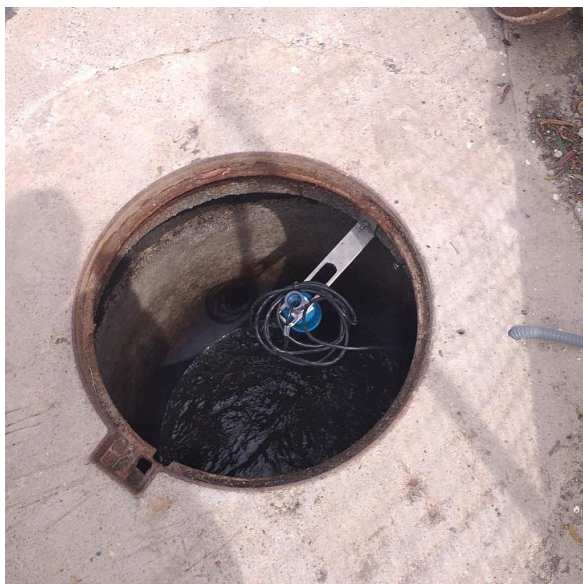
Fotografías de arqueta que alberga sonda de medición y caudalímetro instalados, conectados a telecontrol
