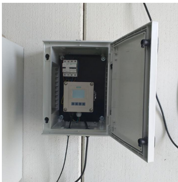
Fotografías de arqueta que alberga sonda de medición y caudalímetro instalados, conectados a telecontrol
