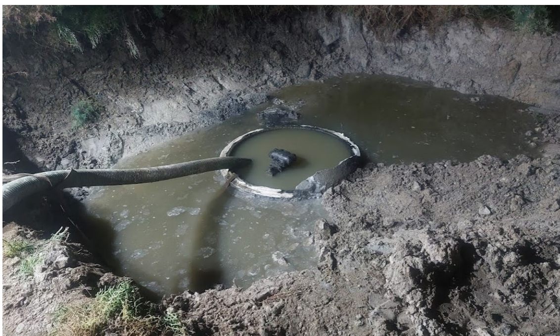
Imagen 4. Vaciado de zanja previo al diagnóstico y reparación.
