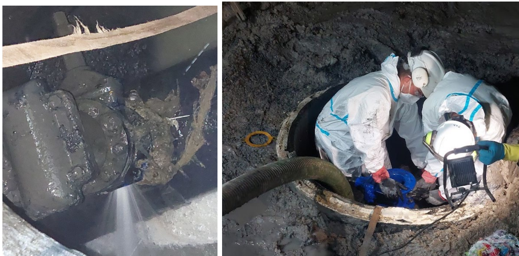
Imagen 5-6. Tareas de reparación.
