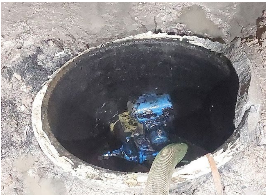
Imagen 7. Finalización de reparación y puesta en marcha.
