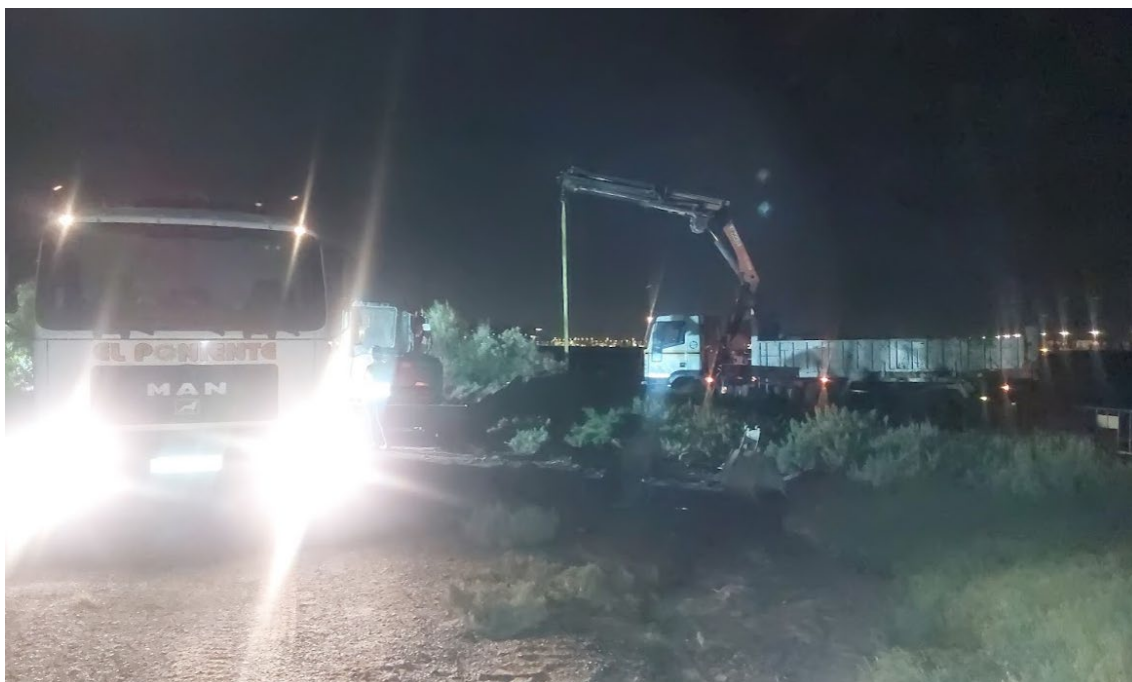
Imagen 3. Camión CIS, excavadora y camión grúa durante la actuación.
