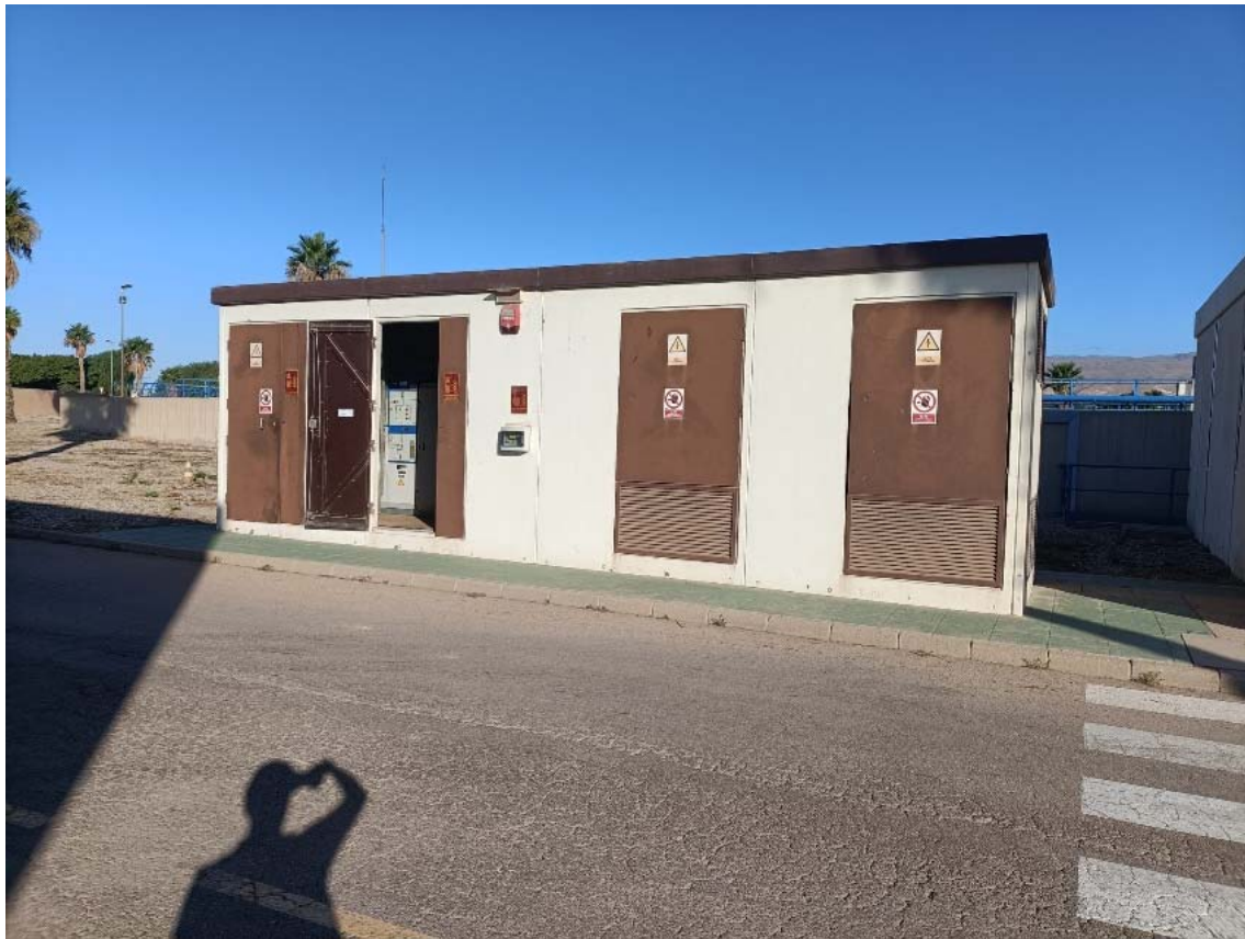
Fotografía 3: Imagen del CT.
