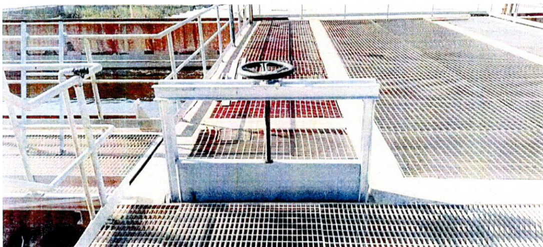
Fotografías de las tres compuertas instaladas en la EDAR Adra
