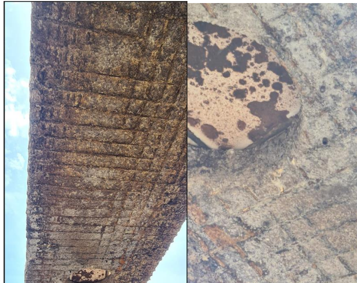
Estado actual pasarela Dep. tampón.
