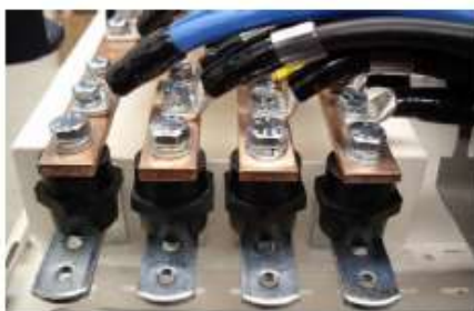
Agrupación de cables en pletina de cobre.
