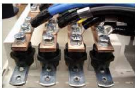
Agrupación de cables en pletina de cobre.
