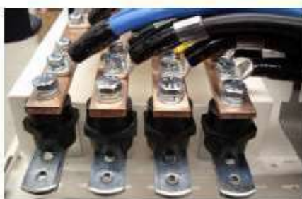
Agrupación de cables en pletina de cobre.
