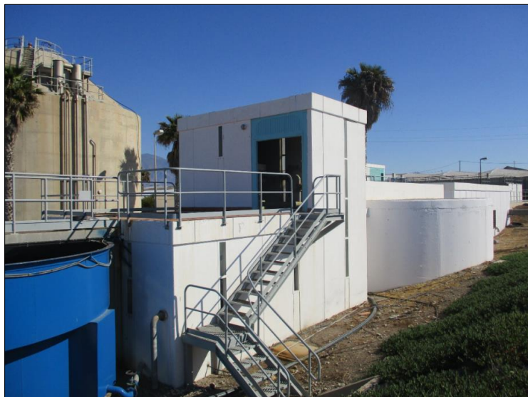
Fotografía 1.- Vista del espesador de fangos por gravedad junto a la arqueta de homogeneización de fangos.
