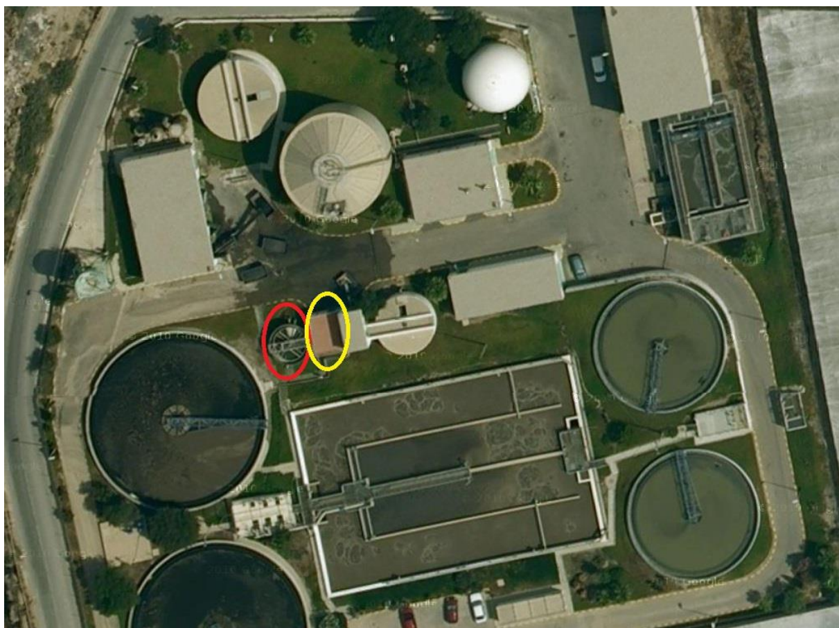
Vista general de la EDAR El Ejido, con el espesador por flotación marcado en rojo y el edificio de presurización en amarillo
