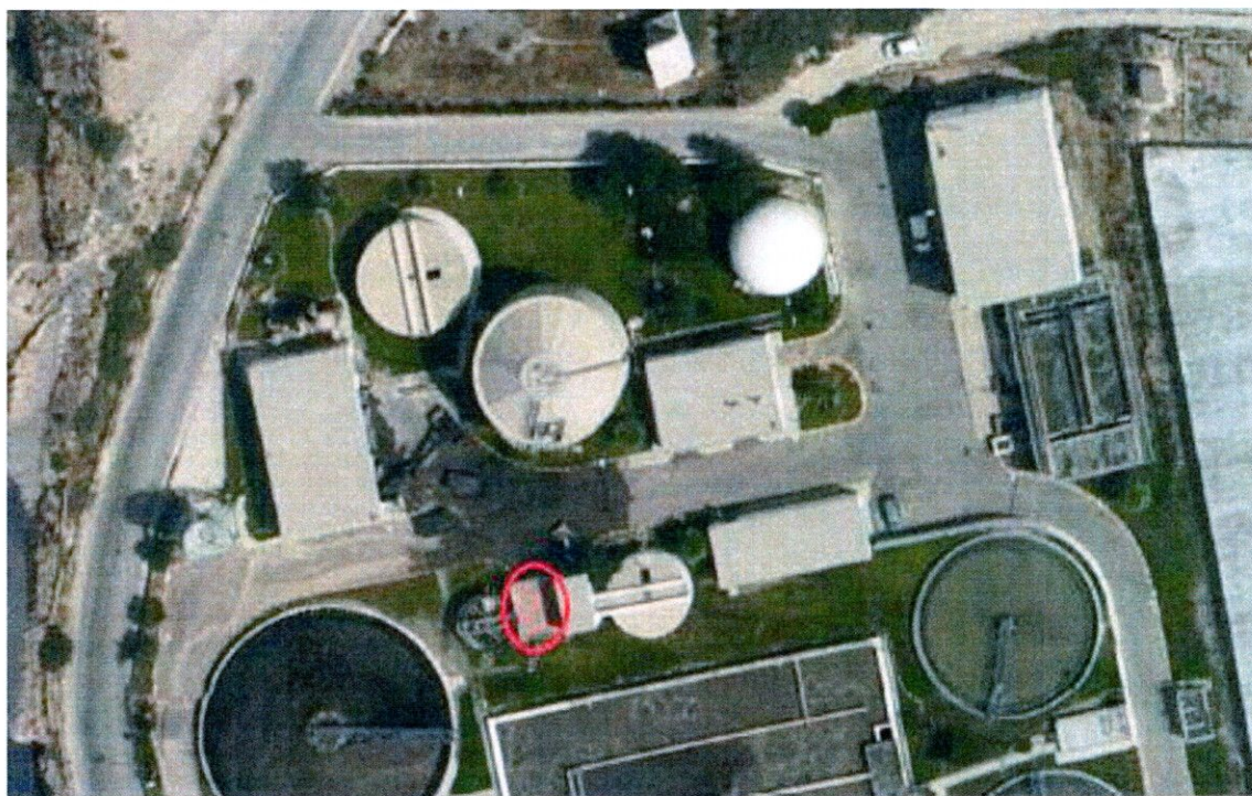
Vista general de la EDAR El Ejido, con el edificio de presurización en rojo, en cuyo sótano se encuentra la actual cámara de mezcla de fangos mixtos
