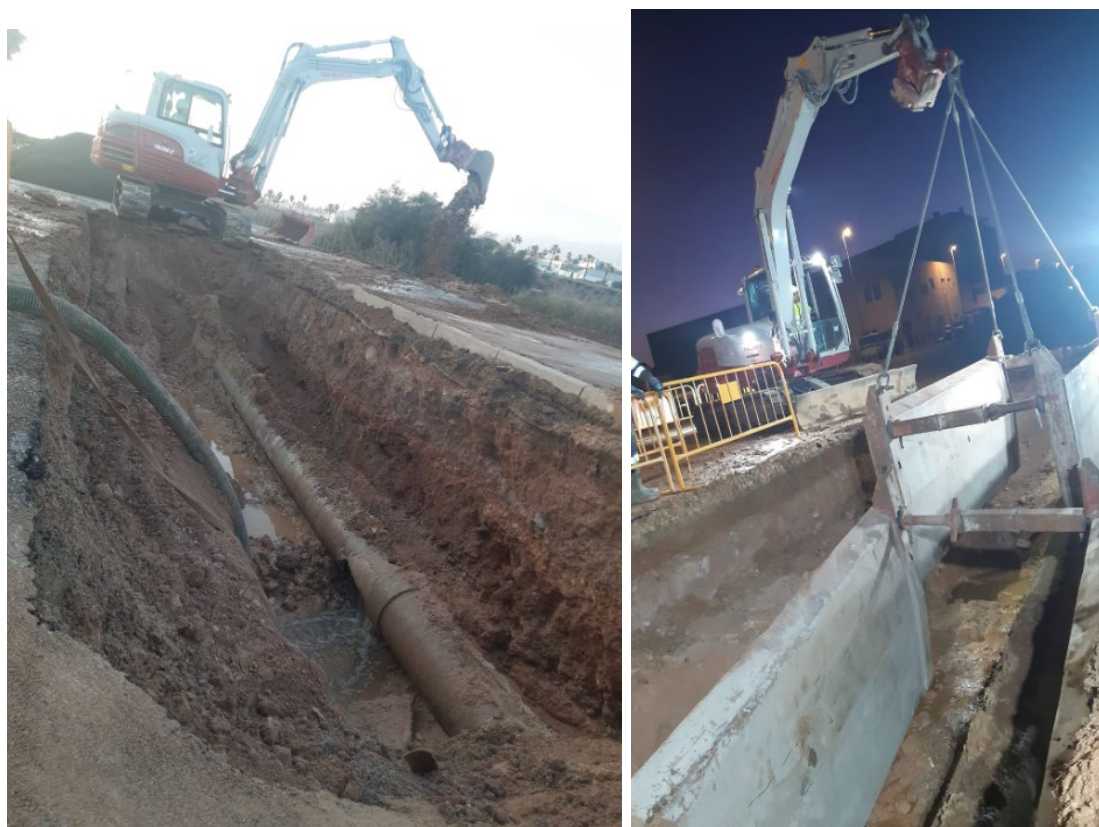
Imagen 5-6. Proceso de reparación y puesta de entibación.
