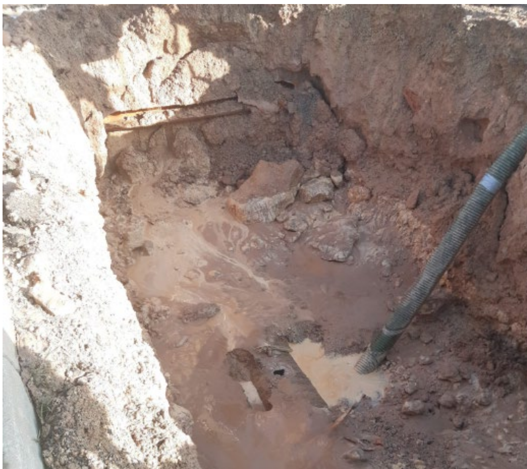
Imagen 3. Vaciado de zanja previo al diagnóstico y reparación.
