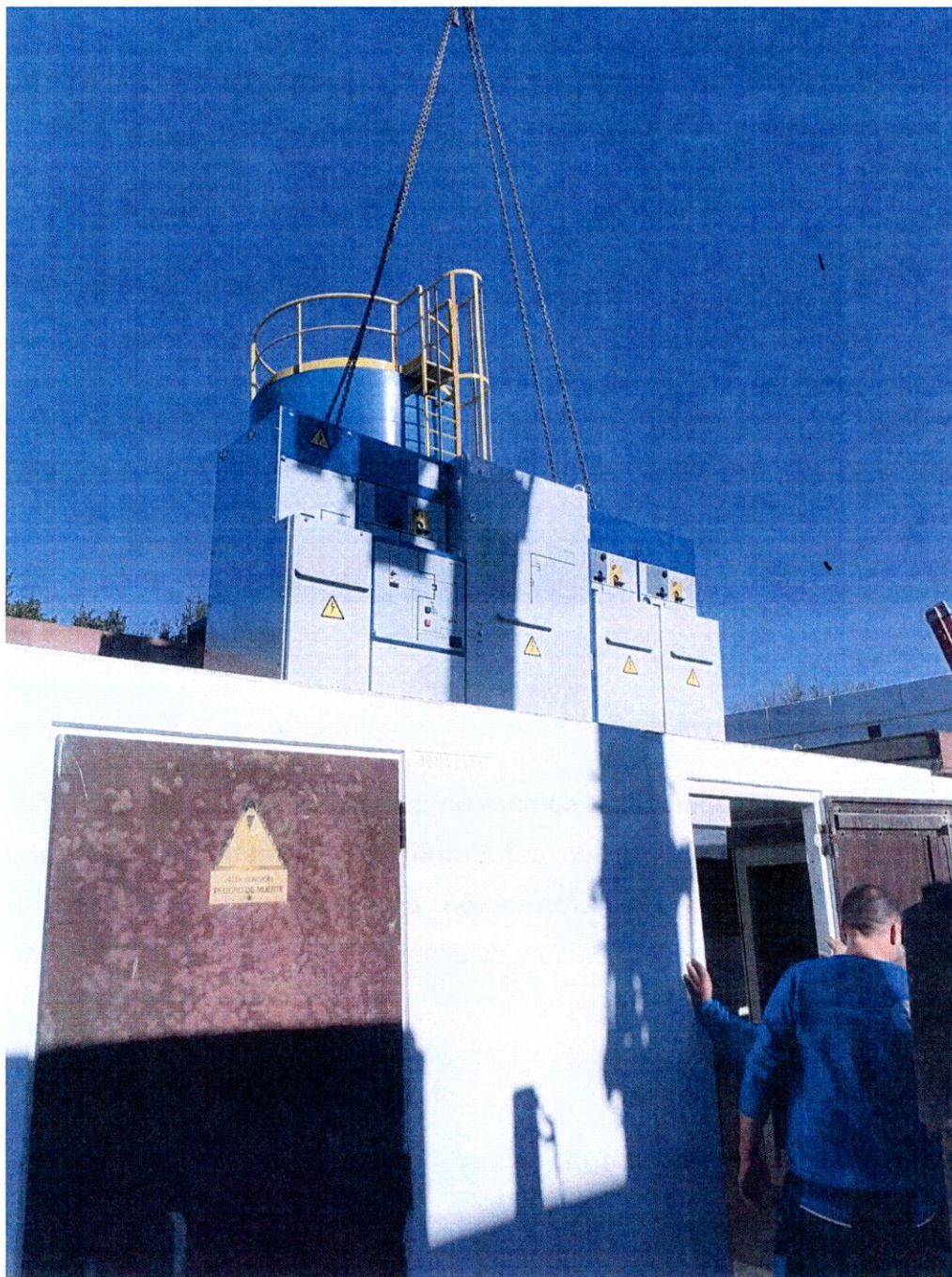
Fotografía de instalación de cabinas nuevas en la EDAR Adra, colocadas desde la parte superior del centro de transformación
