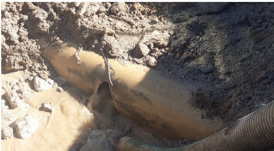
Imagen 3. Vaciado de zanja previo al diagnóstico y reparación.
