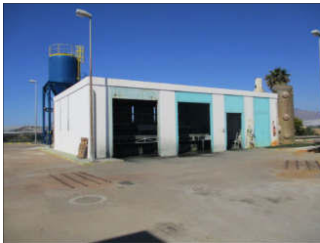
Fotografía 16.- Edificio deshidratación y silo de almacenamiento de fangos.
