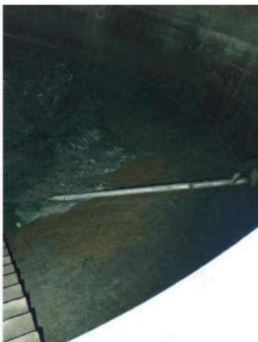
Fotografías del interior del digestor de la EDAR El Ejido, actualmente. Remodelación de obra civil
