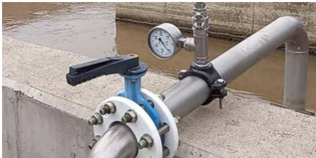
Fotografía de parte del sistema de limpieza mencionado
