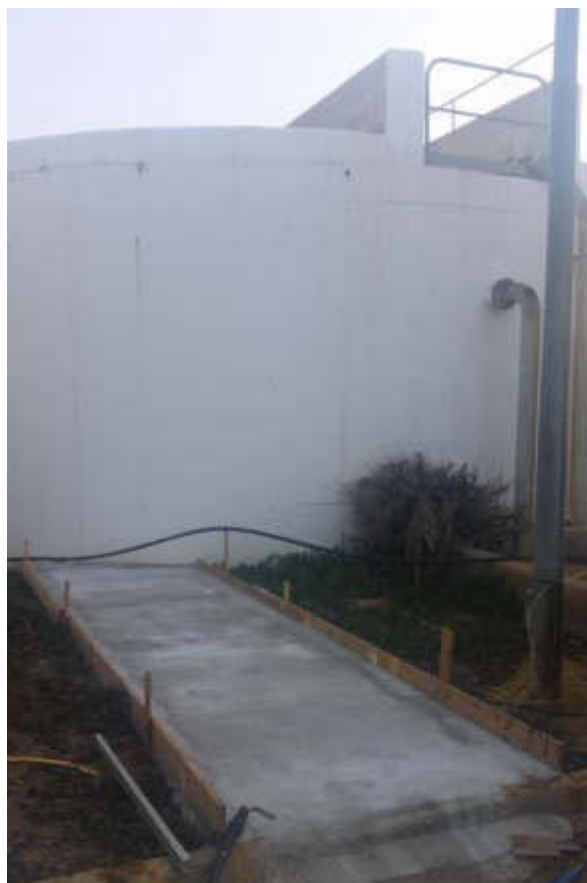
Depósito tampón existente en la EDAR El Ejido
