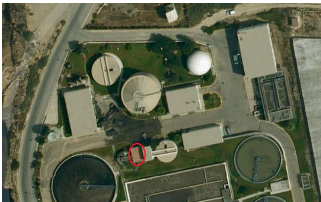
Fotografía de la EDAR El Ejido, con tanque de mezcla de fangos que se redimensionaría rodeado en rojo
