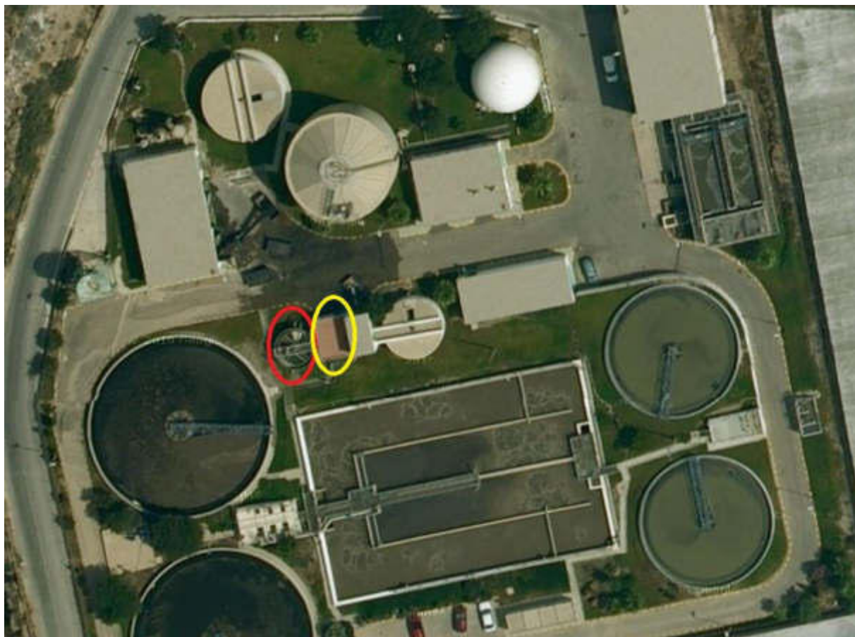
Imagen en planta del flotador (rodeado de rojo) y el edificio de presurización (rodeado de amarillo) donde se encuentran los equipos asociados al flotador
