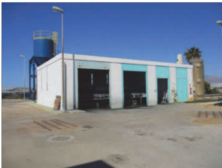
Fotografía 5.- Edificio deshidratación y silo de almacenamiento de fangos.
