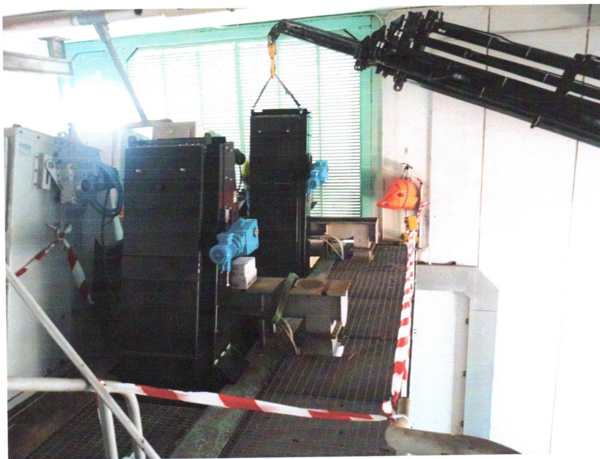
Rejas de la línea manual recientemente instaladas para su automatización y puesta en servicio en continuo
