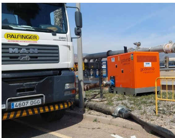
Imagen 2. Preparación de las tareas de llenado.
