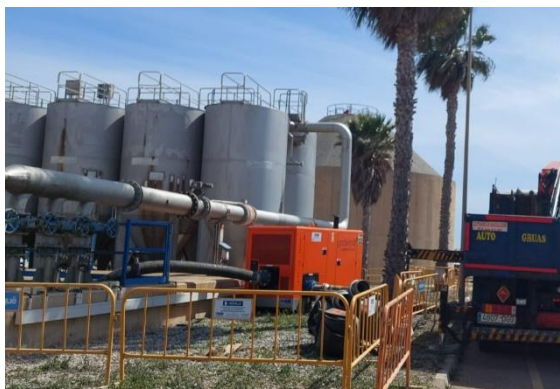
Imagen 1. Preparación de las tareas de llenado.
