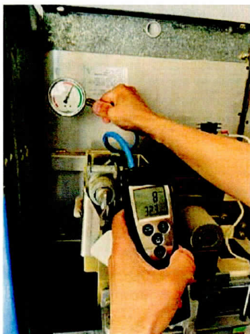
CELDA DE PROTECCION (TRAFO 1)
