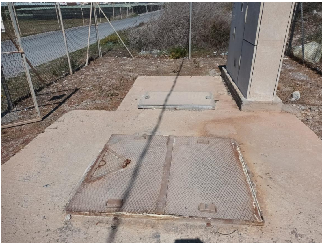
Estado actual tapas EBAR Puente del Río
