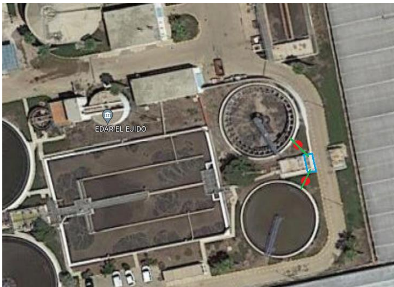
Fotografía de la EDAR El Ejido donde se ubicarían las arquetas con las válvulas PIC en rojo, las conducciones actuales de descarga de los flotantes a través de los “buzones” en verde y el bombeo de flotantes en azul
