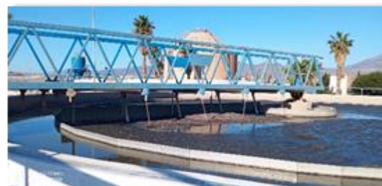
Decantador Primario
