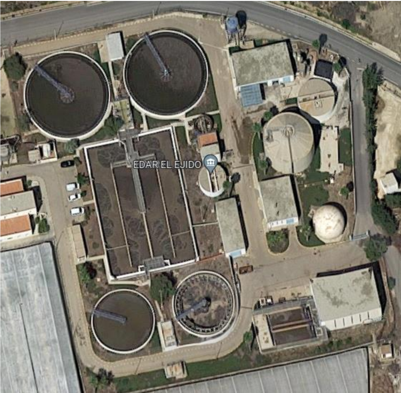
Vista general de la EDAR de El Ejido.
