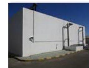
Depósito de agua tratada
