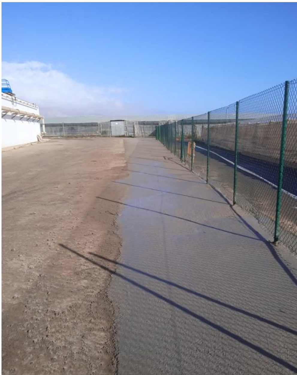
Zona de vallado trasero hormigonada
