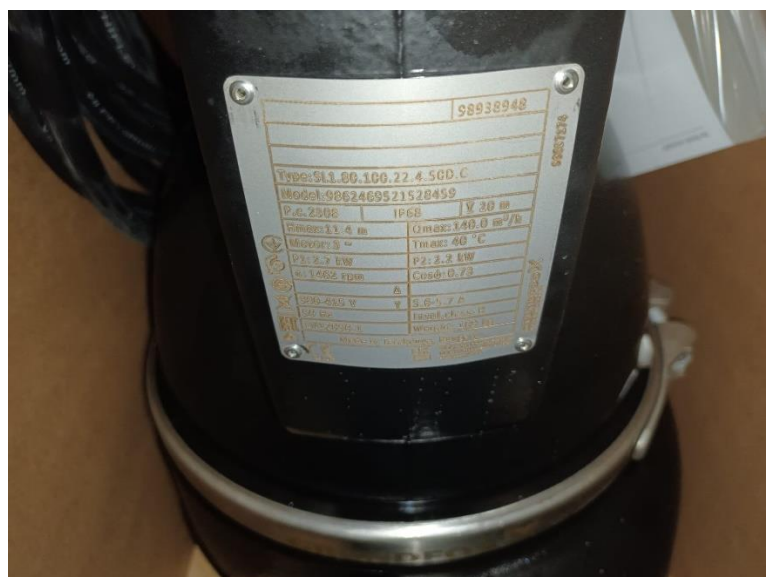
Placas de bombas instaladas
