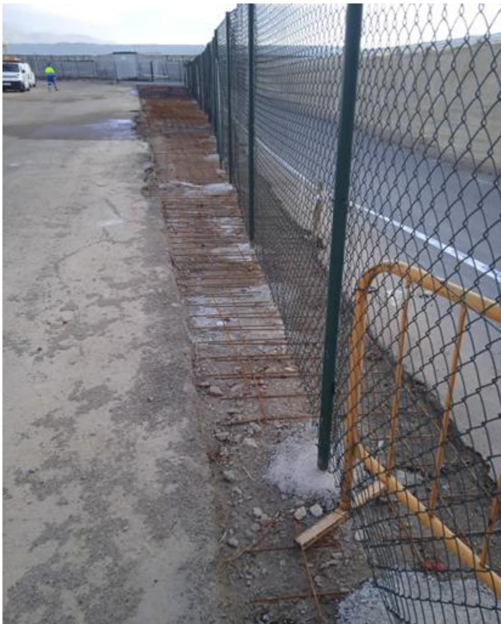
Vallado retranqueado y preparado para hormigonado
