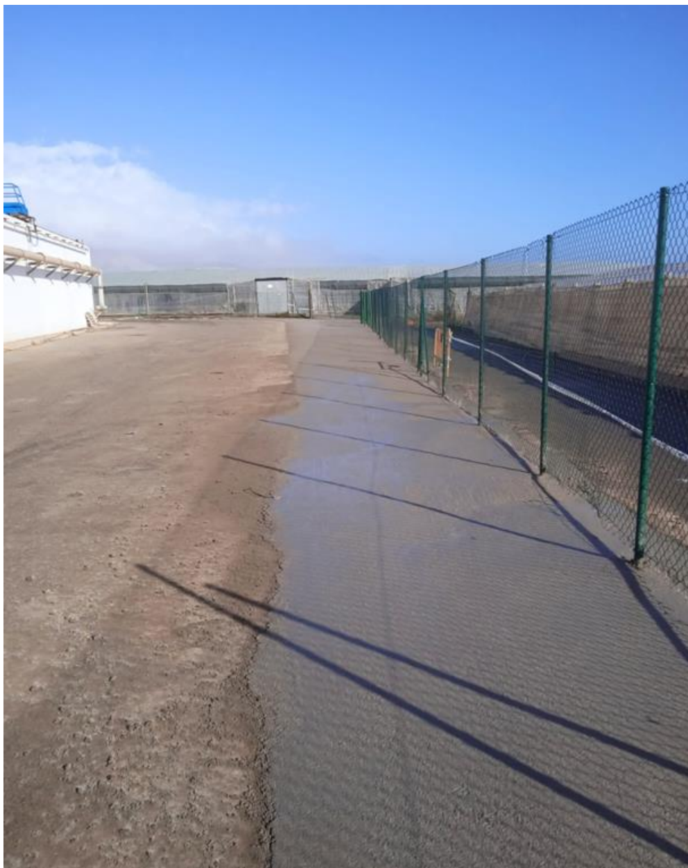
Zona de vallado trasero hormigonada
