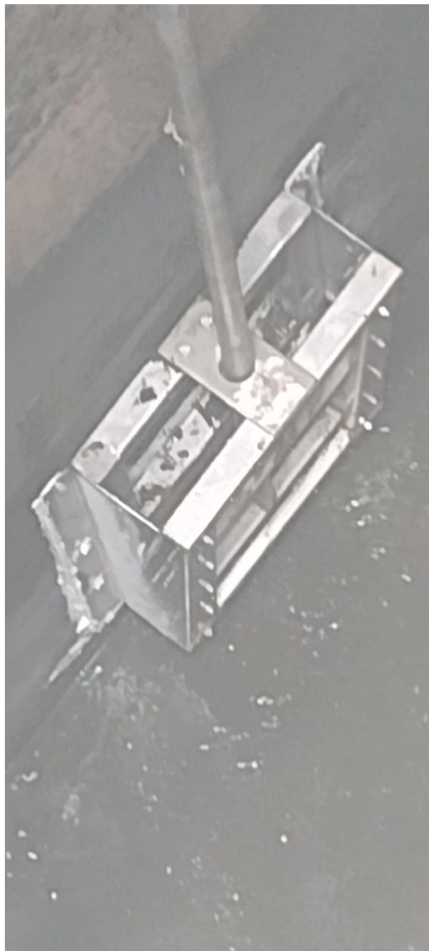
Compuerta de decantador secundario A hacia recirculación desinstalada y nueva instalada
