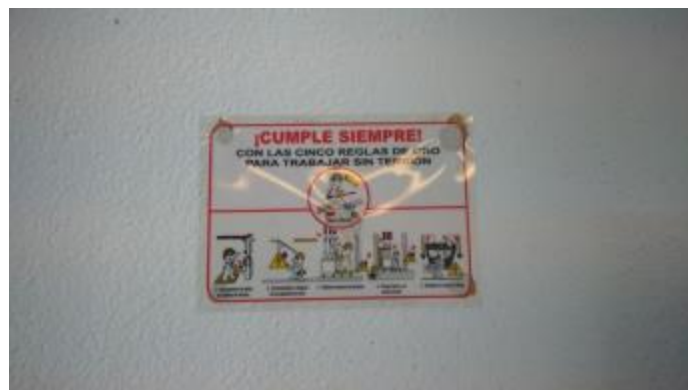
CENTRO DE TRANSFORMACIÓN (d)
