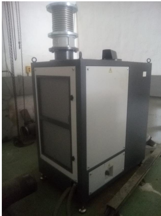
Fotografías de soplante instalada
