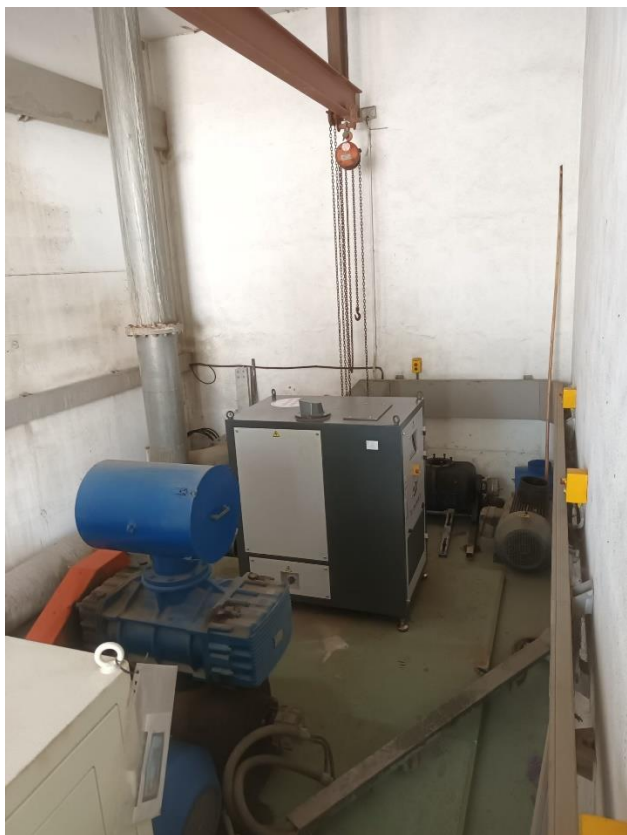
Fotografías de soplante instalada
