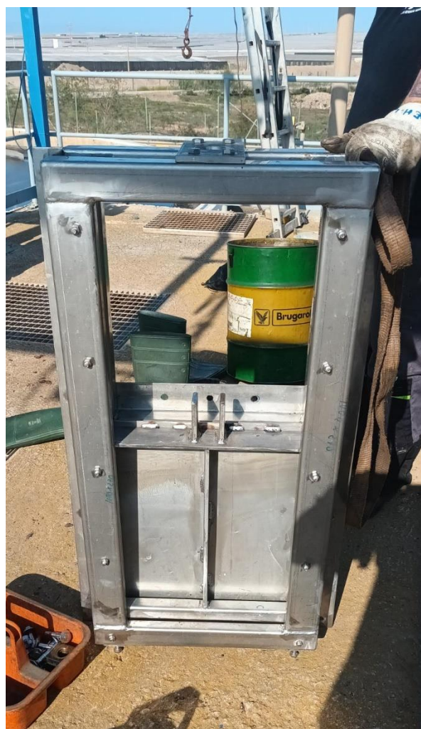
Compuerta de decantador secundario A instalada a la izquierda y compuerta del decantador secundario B a instalar a la derecha
