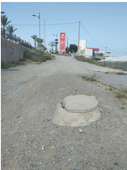
Foto 2: Arqueta intermedia para conexión
