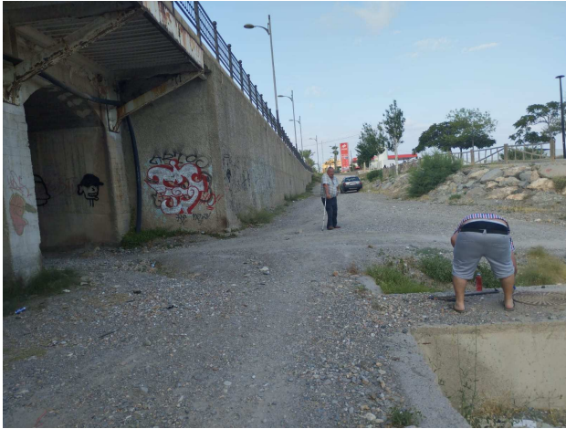
Foto1. Arqueta de conexión con la red
