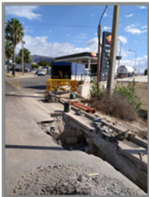
OBRAS DE PROLONGACION DE RED
