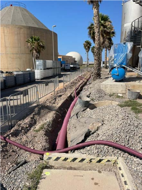
Canalizaciones realizadas para llevar la acometida al cuadro principal de conexión a planta.
