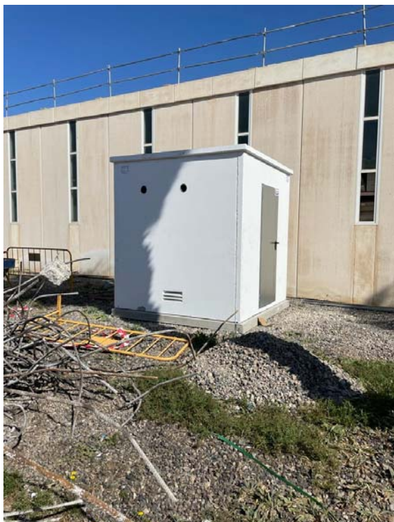
Caseta prefabricada para alojar inversores y cuadros eléctricos, y conectado a arqueta.
