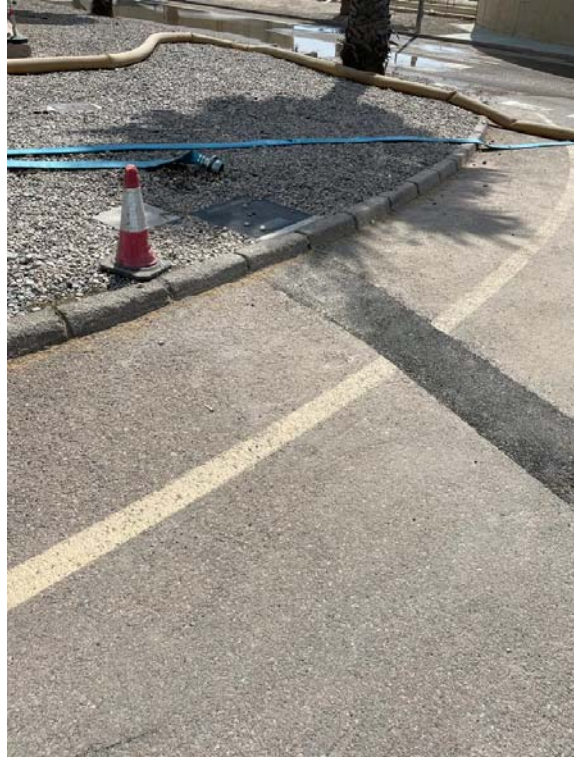
Canalizaciones realizadas para llevar la acometida al cuadro principal de conexión a planta.
