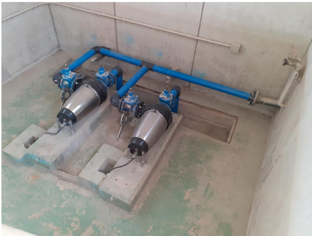
Bombas instaladas, junto con aspiraciones e impulsiones sustituidas
