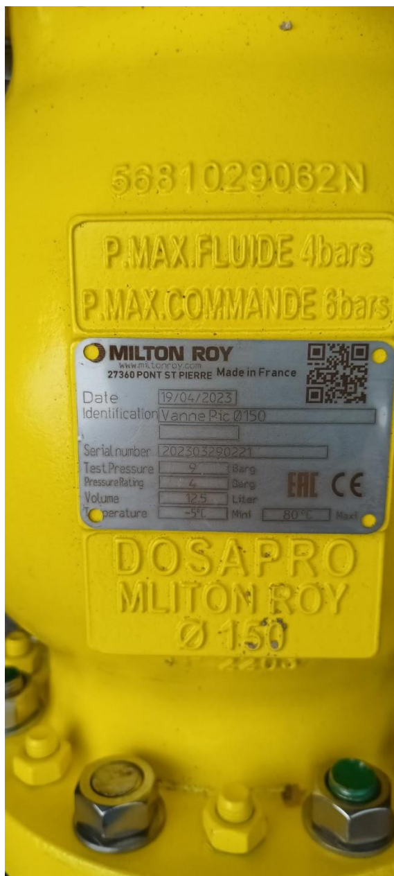
Placa de características de las válvulas PIC instaladas (decantador primario A a la izquierda y B a la derecha)
