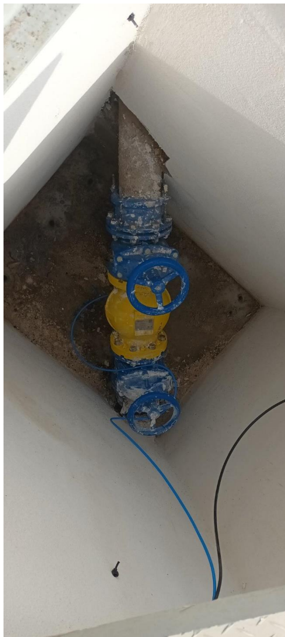
Arqueta de válvula PIC y válvulas de corte instaladas en decantador primario B
