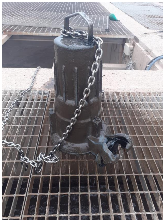
Bombas instaladas en el bombeo de flotantes de los decantadores secundarios de la EDAR Adra
