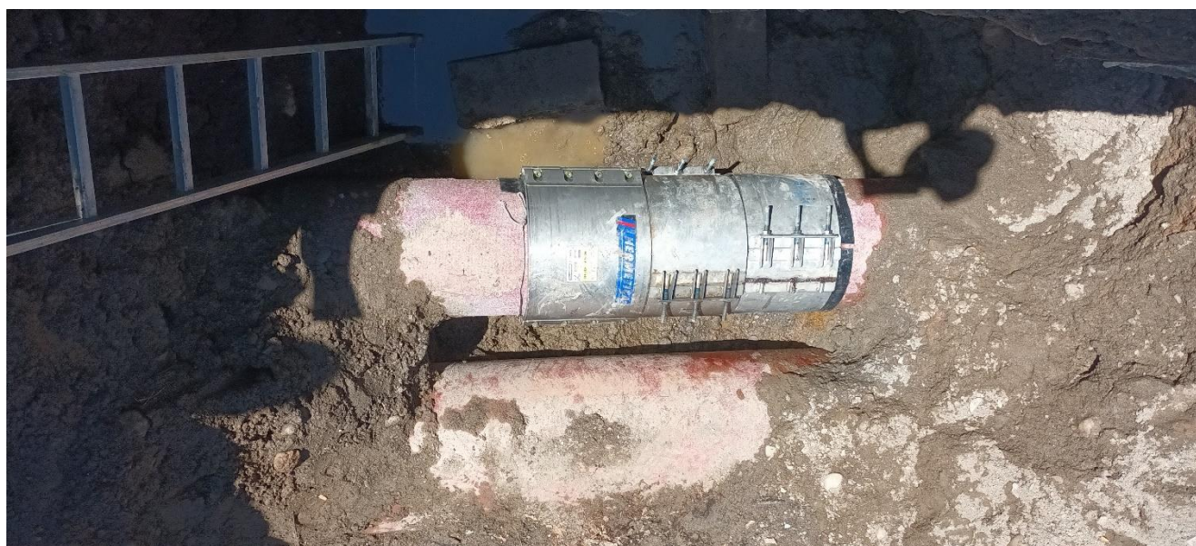
Conducción de impulsión de la EBAR Géminis a la EDAR Adra de FD400 con las 3 abrazaderas de reparación instaladas
