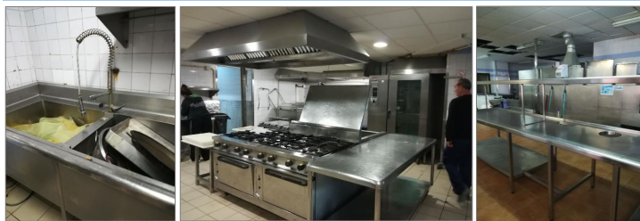
COCINA, LAVAPEROLAS Y TREN DE LAVADO
