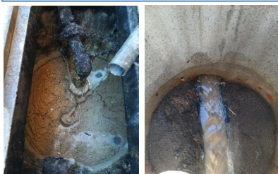
VERTIDO POR BLOQUES A ARQUETAS SIFÓNICAS
