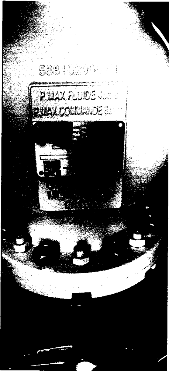
Placa de características de las válvulas PLC instaladas (decantador primario A a la izquierda y B a la derecha)
