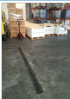
REJILLAS PARA RECOGIDA DE DERRAMES EN EL INTERIOR DE LA NAVE
