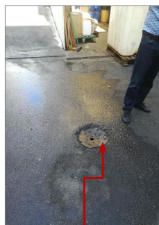
SUMIDERO PLUVIALES A RED MUNICIPAL
