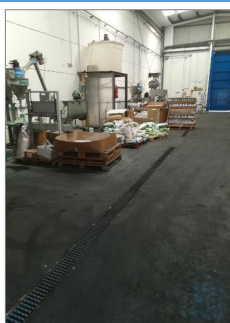
REJILLAS PARA RECOGIDA DE DERRAMES EN EL INTERIOR DE LA NAVE
