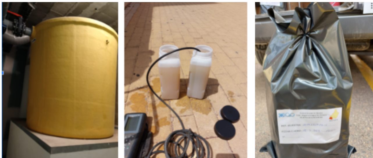
Instalacion de Separador de grasas para adecuacion del vertido. Toma de muestras
