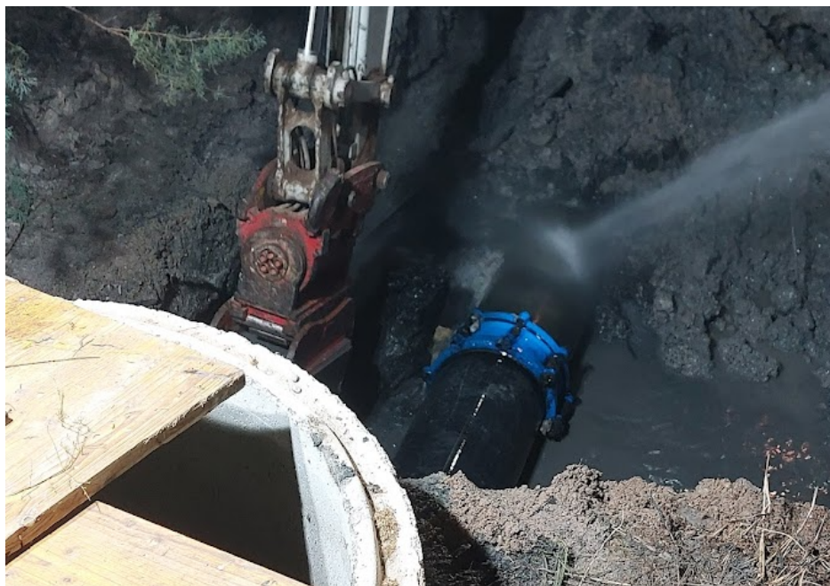
Imagen 3. Vaciado de zanja previo al diagnóstico y reparación.
