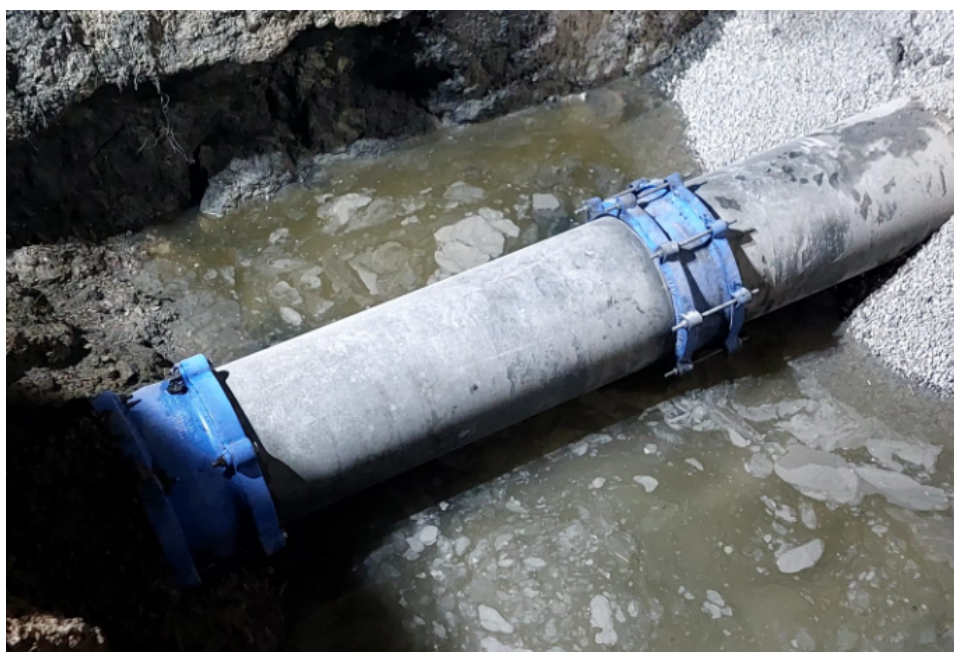
Imagen 4. Finalización de reparación y puesta en marcha.
