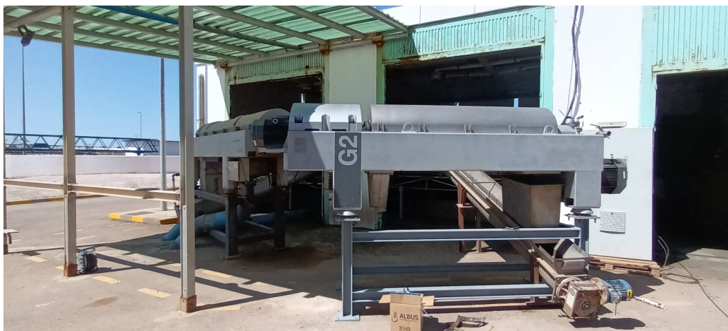
Fotografía con las dos centrifugas en operación la existente y la alquilada (en primer plano)
