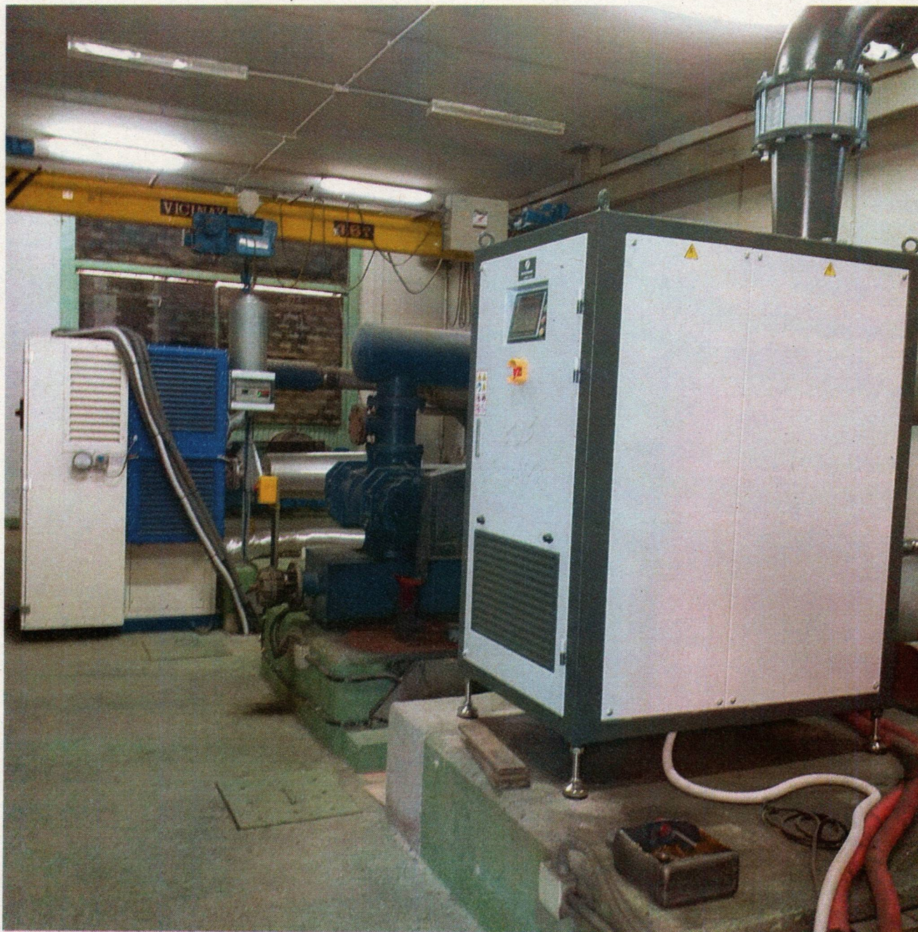
Soplante de levitación magnética a la izquierda, Mapner lobular en el centro y de levitación por aire a la derecha
