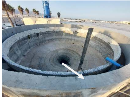
Detalle del punto donde termina la escalera de acceso.
