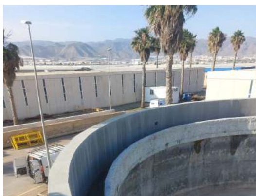
Detalle del estado del tampón una vez rehabilitado.
