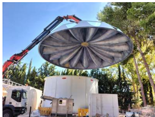
Detalle de la colocación de una cubierta similar.
