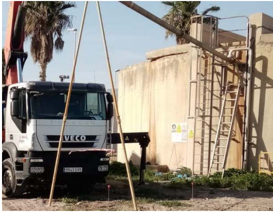
Detalle del antiguo acceso por donde discurrirá la nueva escalera.
