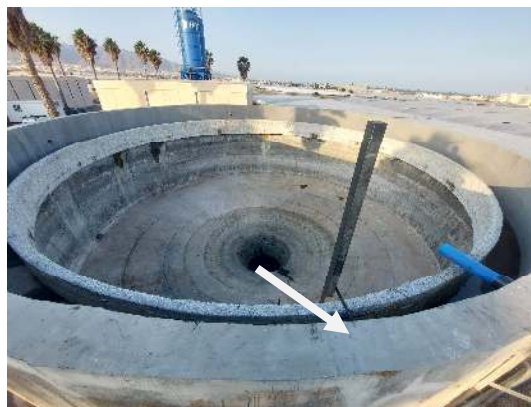
Detalle del punto donde termina la escalera de acceso.
