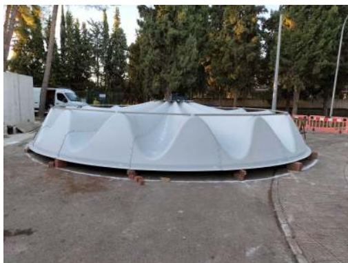
Detalle de una cubierta similar premontada.
