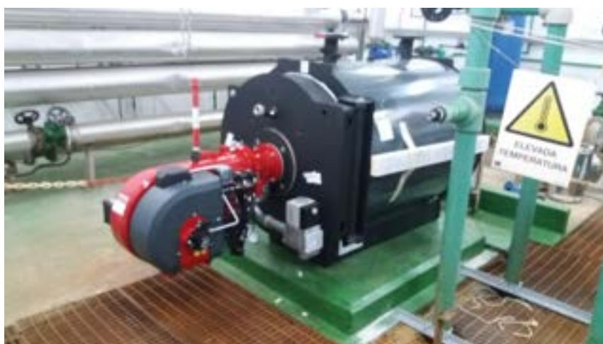
Suministro e instalación de nueva caldera.
