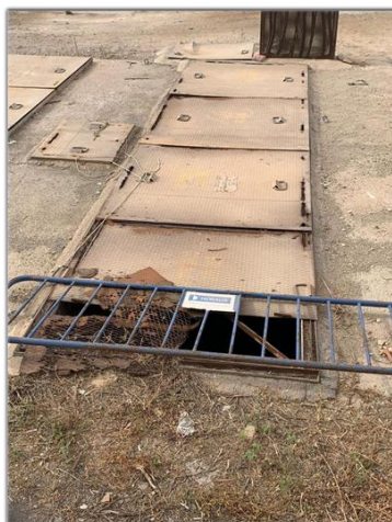
Imagen 1. EBAR Pso. Los Baños
