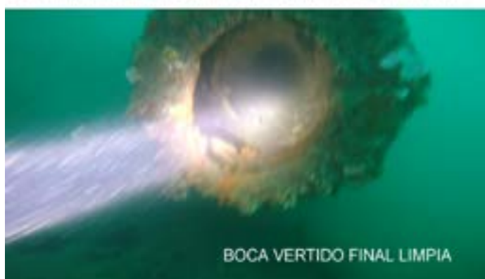
BOCA VERTIDO FINAL EMISARIO -33 m PROFUNDIDAD. ANTES Y DESPUES REPARACION
