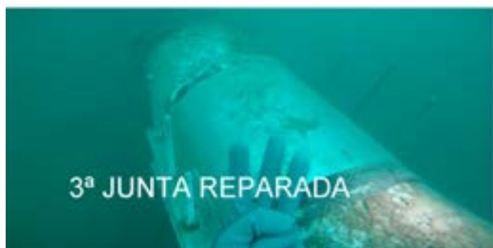
TERCERA ROTURA. ANTES Y DESPUÉS REPARACIÓN
