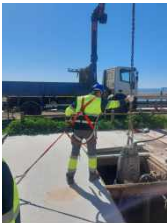
Fotografía durante el montaje de la bomba de reserva de la EBAR Las Salinas.
