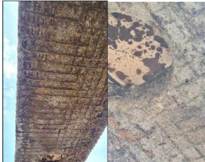
Estado actual pasarela Dep. tampón.
