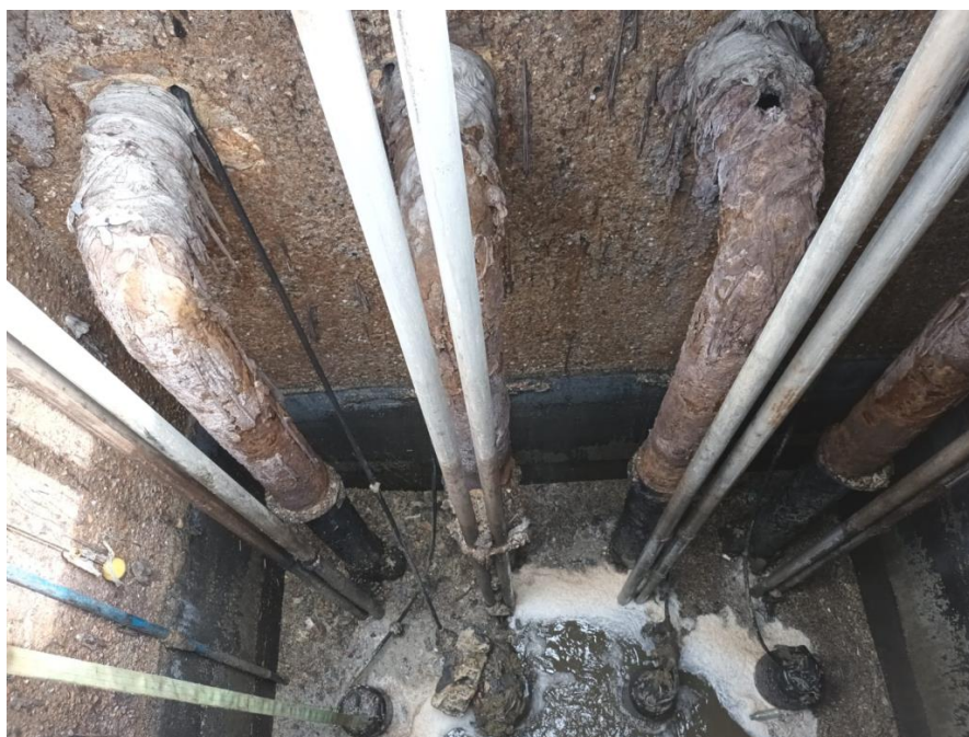
Estado impulsiones actuales EBAR Géminis
