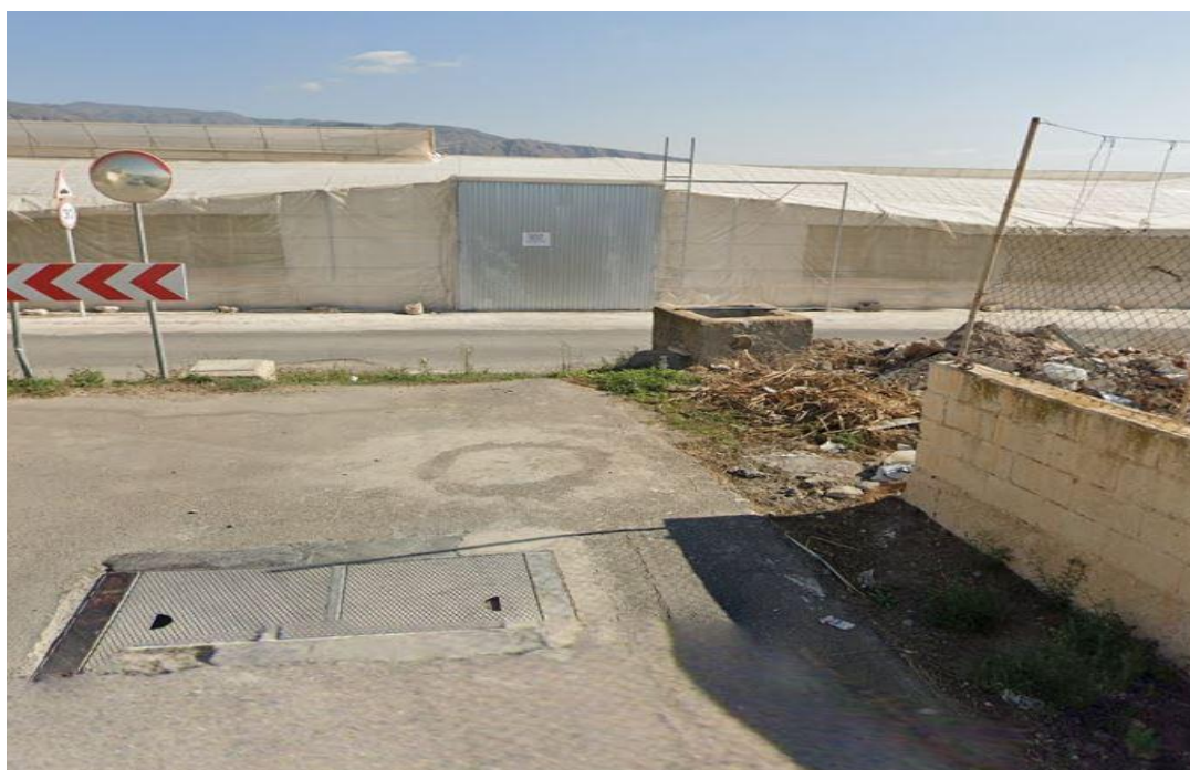
Foto BOMBEO CALLE LANZAS (google maps)
