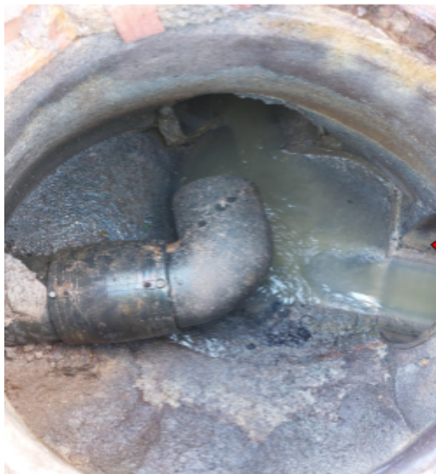
FOTO PUNTO TOMA DE MUESTRA. Punto de descarga del bombeo c/lanzas
